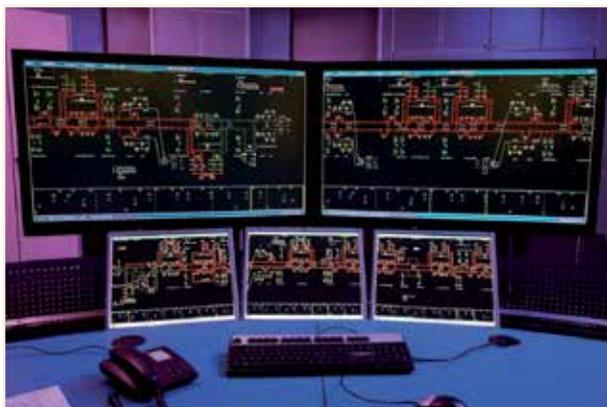
Tutte le apparecchiature delle sottostazioni e delle linee elettriche sono comandate e controllate tramite nuovi sistemi "DOTE AV", con i quali è possibile garantire la continuità di esercizio anche in caso di anomalie, controllare lo stato delle diverse apparecchiature e i valori della tensione e della corrente di linea
